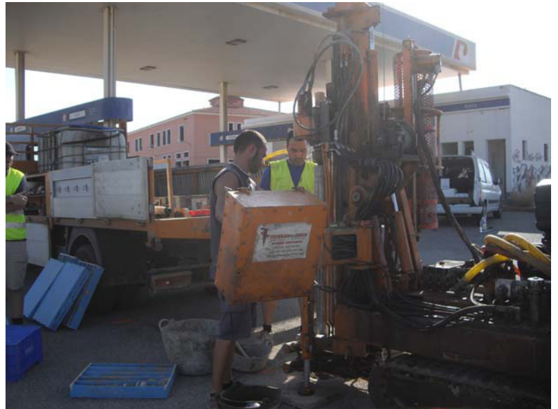
Sondeo J1 en EE.SS “Petronor”
