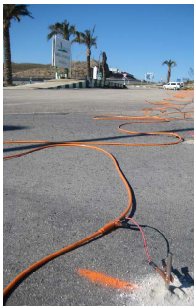
Foto 3.1. Conexión electrodo de metal – cable multiconductor mediante pinza.
