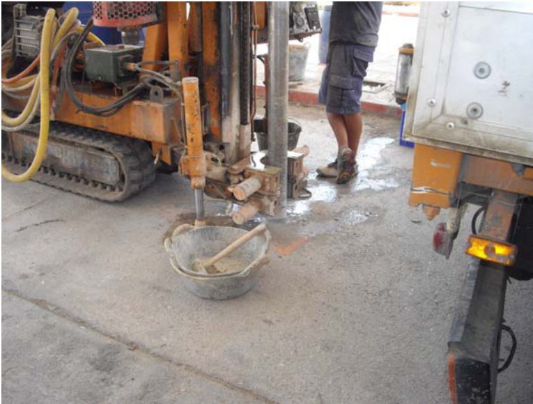
Sondeo J3 en EE.SS "Petronor"
