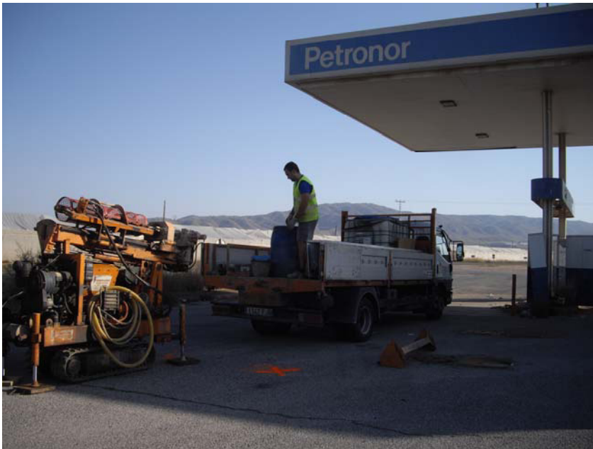
Localización de maquinaria en el lugar señalado para realizar la toma de muestras en EE.SS “Petronor”
