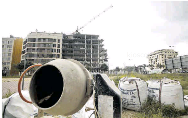
Obras de construcción en el ensanche norte de la ciudad de Murcia.
