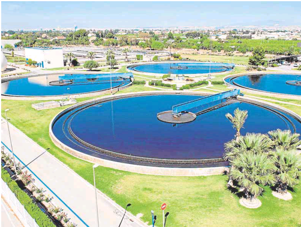
Estación Depuradora de Aguas Residuales (EDAR) Murcia Este. JAVIER CARRIÓN / AGM
