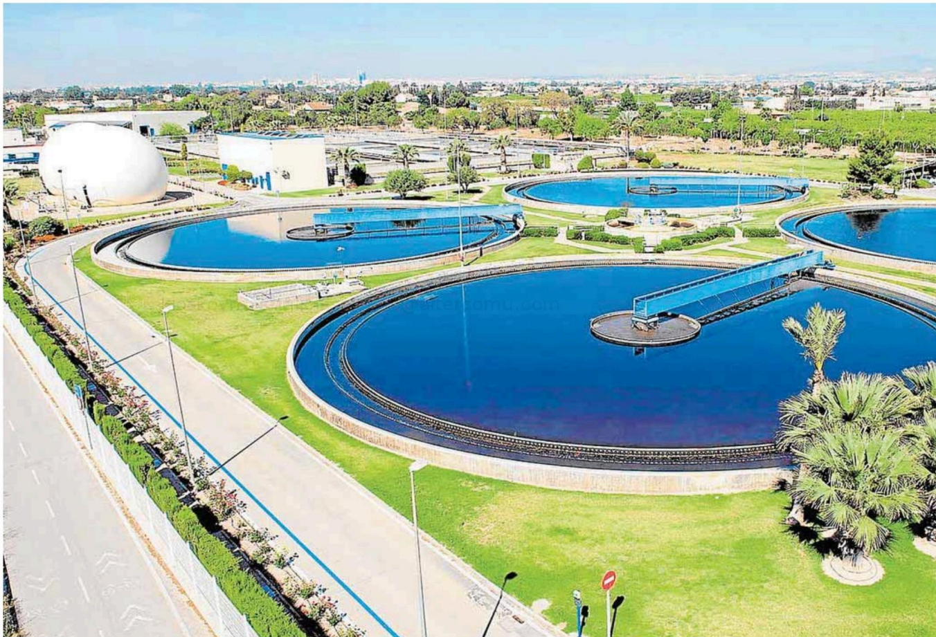
Estación Depuradora de Aguas Residuales (EDAR) Murcia Este en la pedanía de Llano de Brujas, junto al río Segura. JAVIER CARRIÓN / AGM
